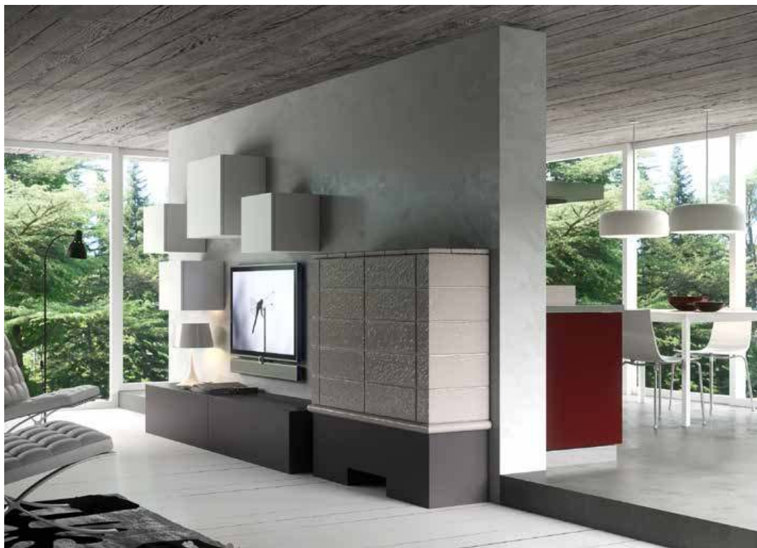
Nachheizwand verkachelt, die es erlaubt, die Wärme des Pertinger Küchenherdes aufzunehmen und für einige Stunden zu speichern
