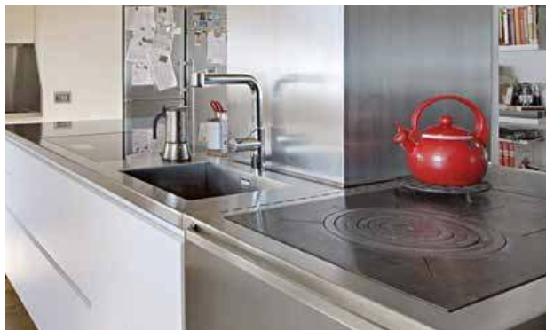
SPÜLE AUS EDELSTAHL FUGENLOS EINGESCHWEISST, HERDRELING MIT PROFILROHR FLÄCHENBÜNDIGES KOCHFELD
