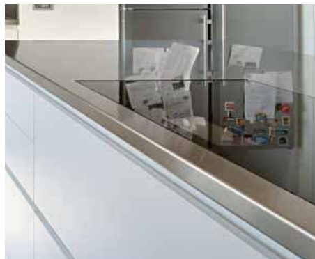
SPÜLE AUS EDELSTAHL FUGENLOS EINGESCHWEISST, HERDRELING MIT PROFILROHR FLÄCHENBÜNDIGES KOCHFELD
