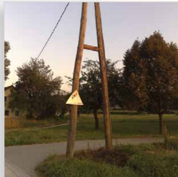
Električni steber, zaščiten s Silvaproduktivnim izdelkom, ki je bil pred več kot 30 leti zakopan v zemljo brez betonskih distančnikov, še danes opravlja svojo nalogo.
