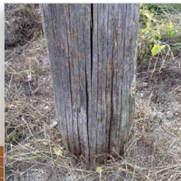
Električni steber, zaščiten s Silvaproduktivnim izdelkom, ki je bil pred več kot 30 leti zakopan v zemljo brez betonskih distančnikov, še danes opravlja svojo nalogo.
