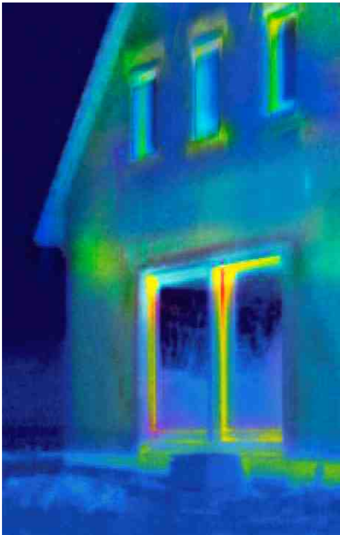
Pred obnovo: velike toplotne izgube so na sliki predstavljene z rdečo barvo
